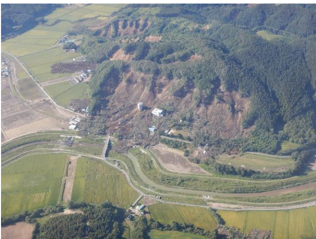
ヘリコプターから確認した斜面崩壊(9月6日国総研撮影)
