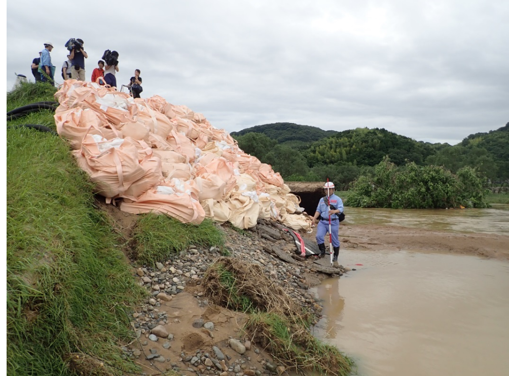
小田川にて堤防の崩壊・決壊状況を調査する国総研職員(7月8日)
