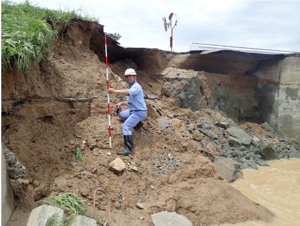
小田川にて堤防の崩壊・決壊状況を調査する国総研職員(7月8日)
