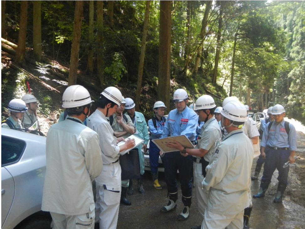
現地で調査内容の打合せを行う国総研職員(7月10日)
