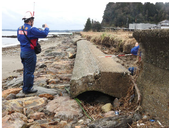
護岸の波返工の転倒状況を確認
