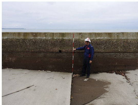
護岸の天端被覆工の沈下状況を確認
