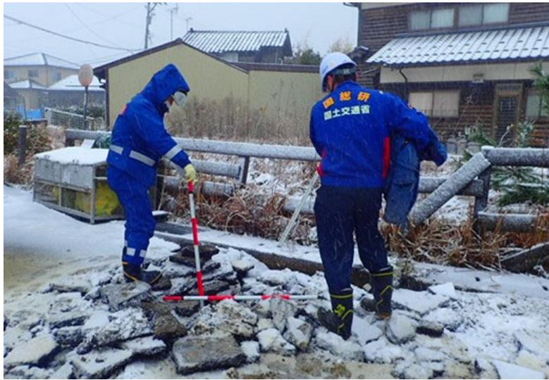
液状化現象により破損したマンホールポンプの調査の様子(羽咋市内)(1月13日)
