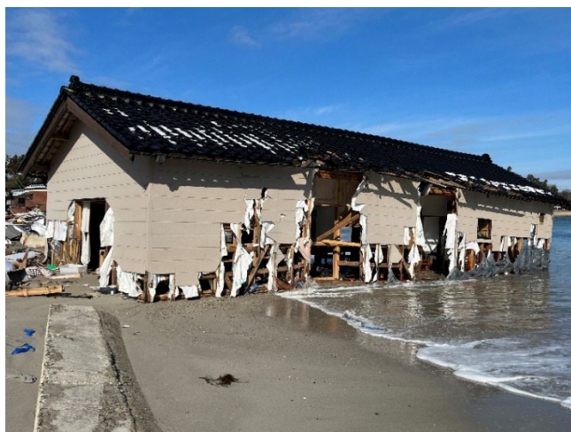
津波の引き波による住宅2階部分の流出状況 （1月14日・能登町）
