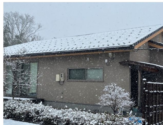
ガイドライン工法による瓦屋根の無被害の状況 （1月13日・珠洲市）
