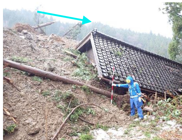
流出土砂による家屋被害の状況
