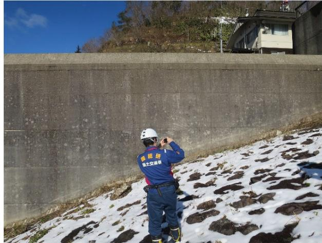
地震による堤体の沈下を確認
