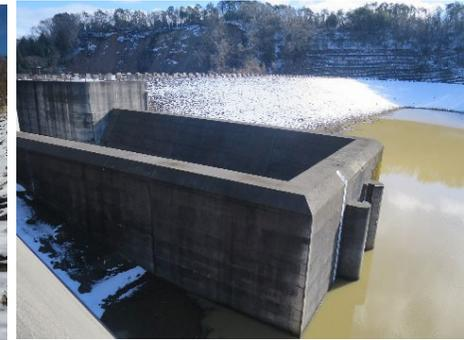
堤体の沈下が確認されたものの洪水吐き本体の損傷は見られなかった。
